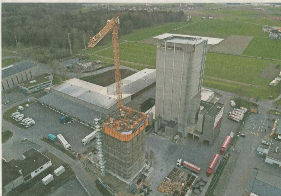
Das neue Silo im Burgdorfer Industriequartier wird mit der Gleitschalungstechnik betoniert. Fotos: Beat Mathys
